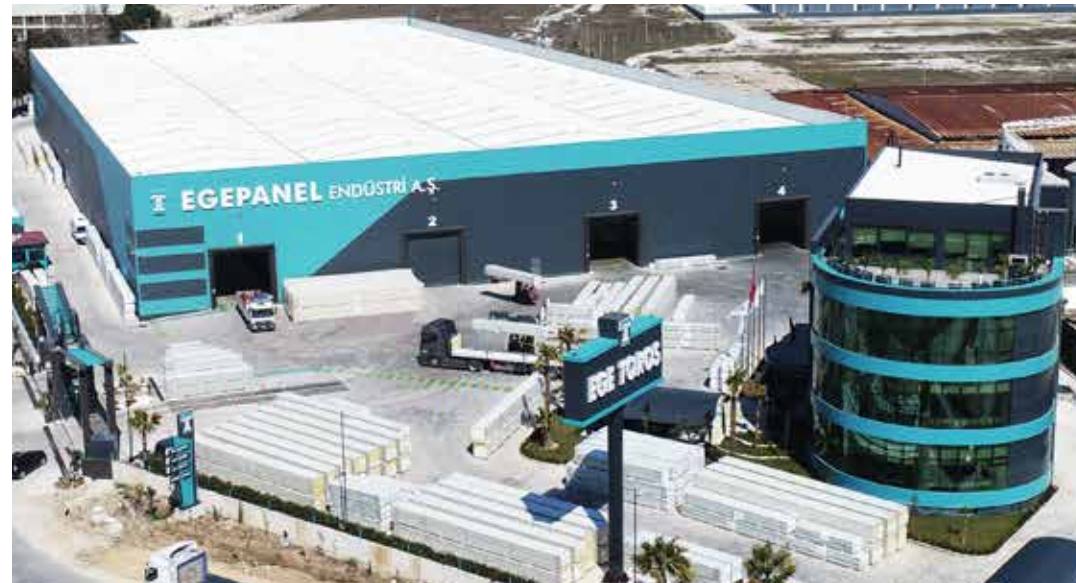
Torbalı - EgePanel Endüstri A.Ş. Sandviç Panel Üretim Tesisi
